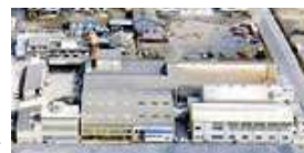
川棚電炉工場
